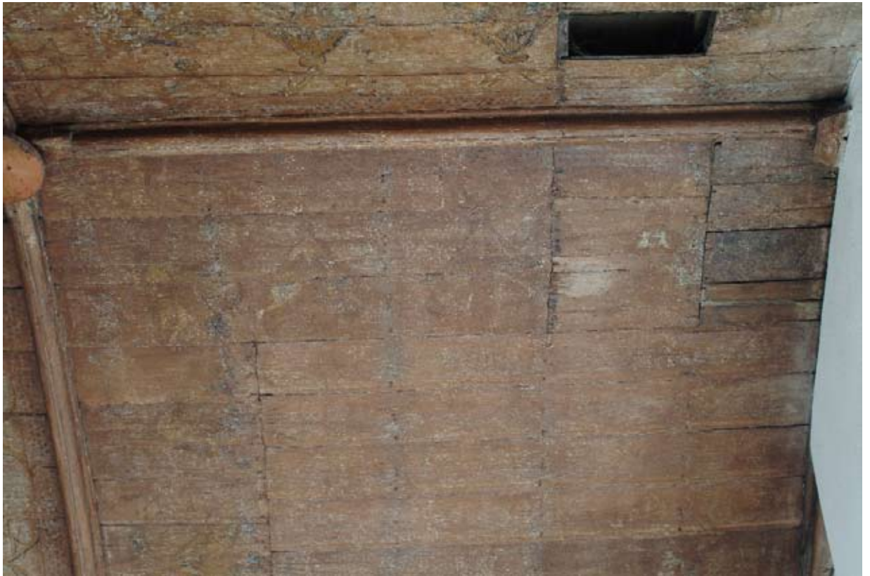
VOOR DEMONTAGE BOVENKANT VAK MET SLUITPLANKEN
