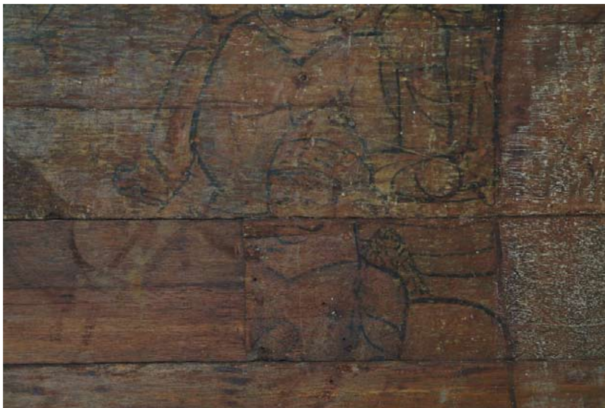
VOOR DEMONTAGE VERKEERDE AANSLUITING PLANKEN
