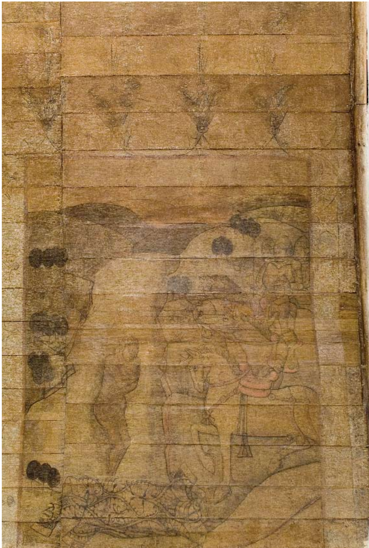
NA RESTAURATIE IN DE KAP
